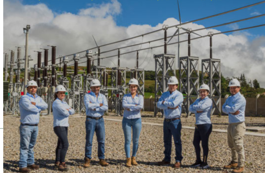
Parque eólico Duna Huambos - Perú
