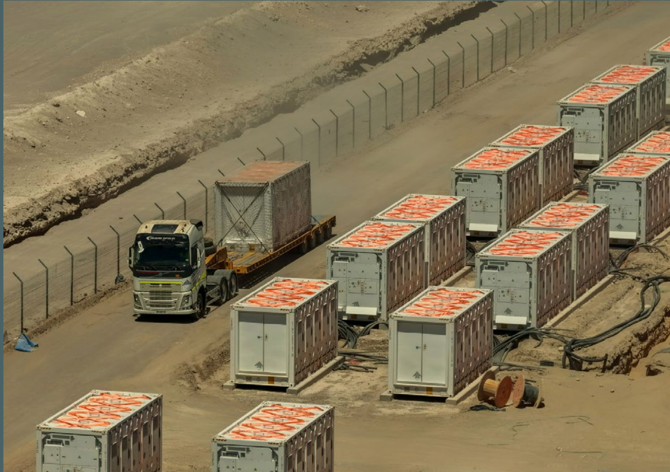
Montaje de baterías planta híbrida Elena 446 MW + 3,5 GWh, Chile
