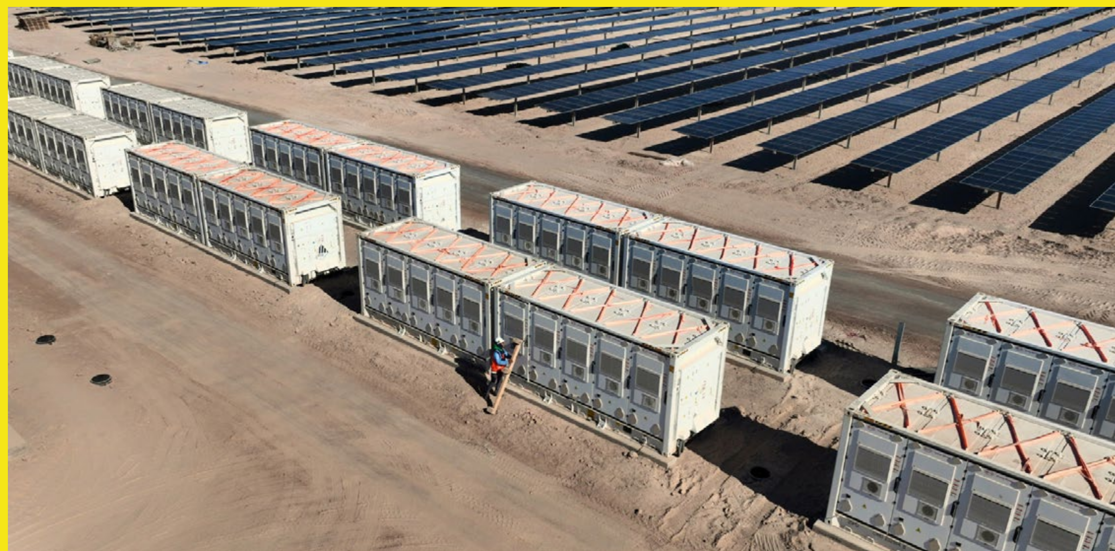
Montaje de baterías en planta híbrida Elena 446 MW + 3,5 GWh, Chile
