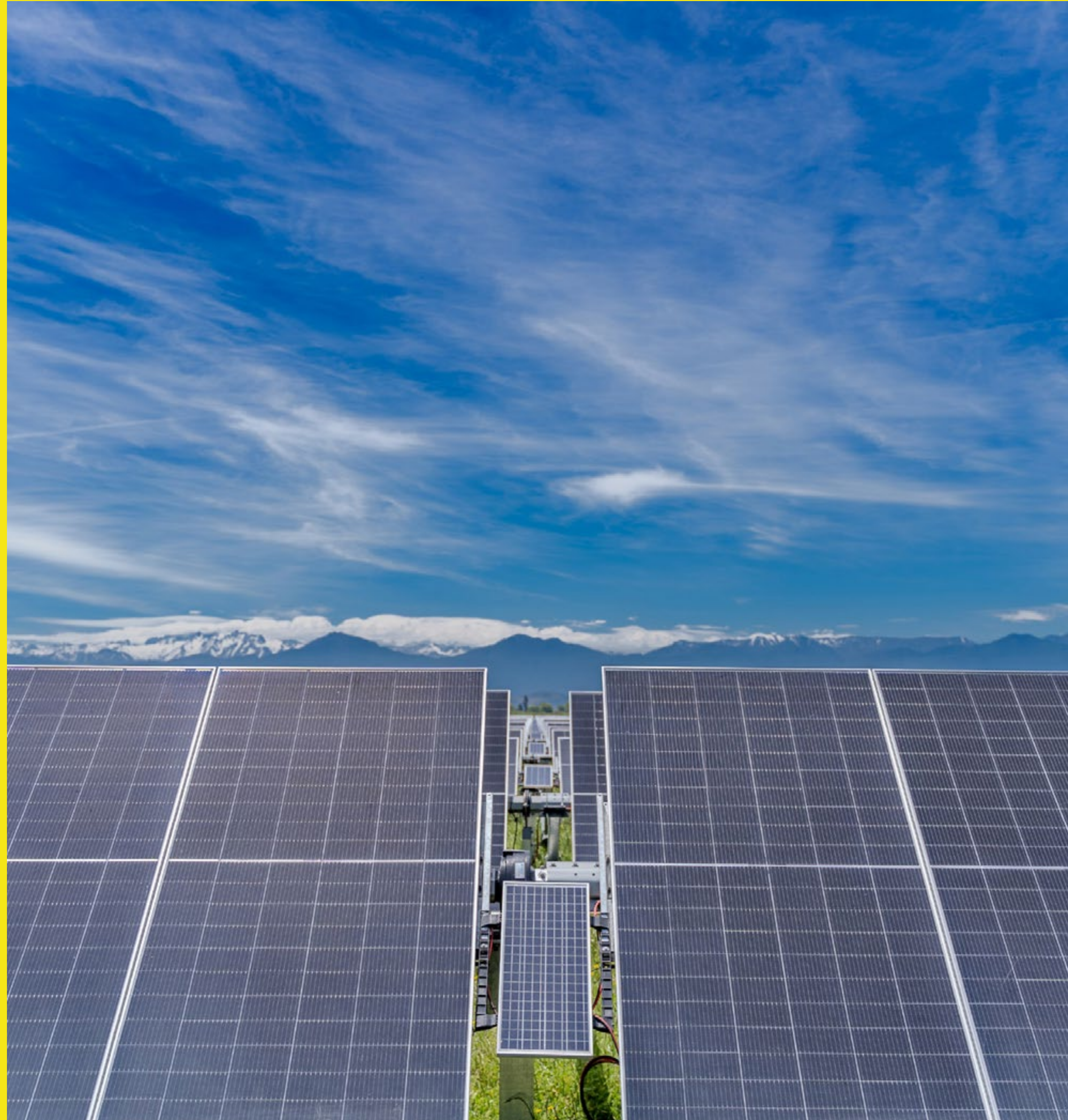
Gran Teno 200 MW PV plant, Chile
